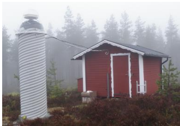
Figur 3 En klass A-station i Leksand med pelarmonterad antenn och tillhörande utrustning i en friggebod. Källa: SWEPOS Klassificering
